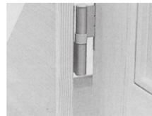
■ドア本体上部の丁番の軸を引き下げながらドア枠上部の丁番に位置を合わせ、軸を戻します。
